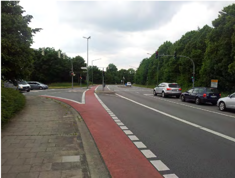
Einmündung Rheiner Landstraße / An der Blankenburg (Zufahrt Rheiner Landstraße Osten)
